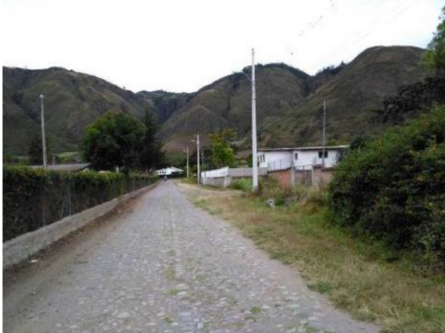
Foto: Vías internas comunidad Yahuarcocha
