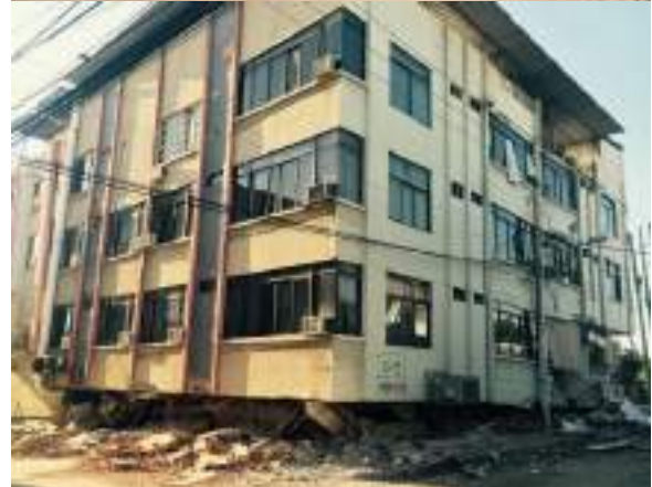
Imagen 17: Paredes falladas en ampliación con estructura metálica. Sismo de Manabí. (Suarez, 2016)
