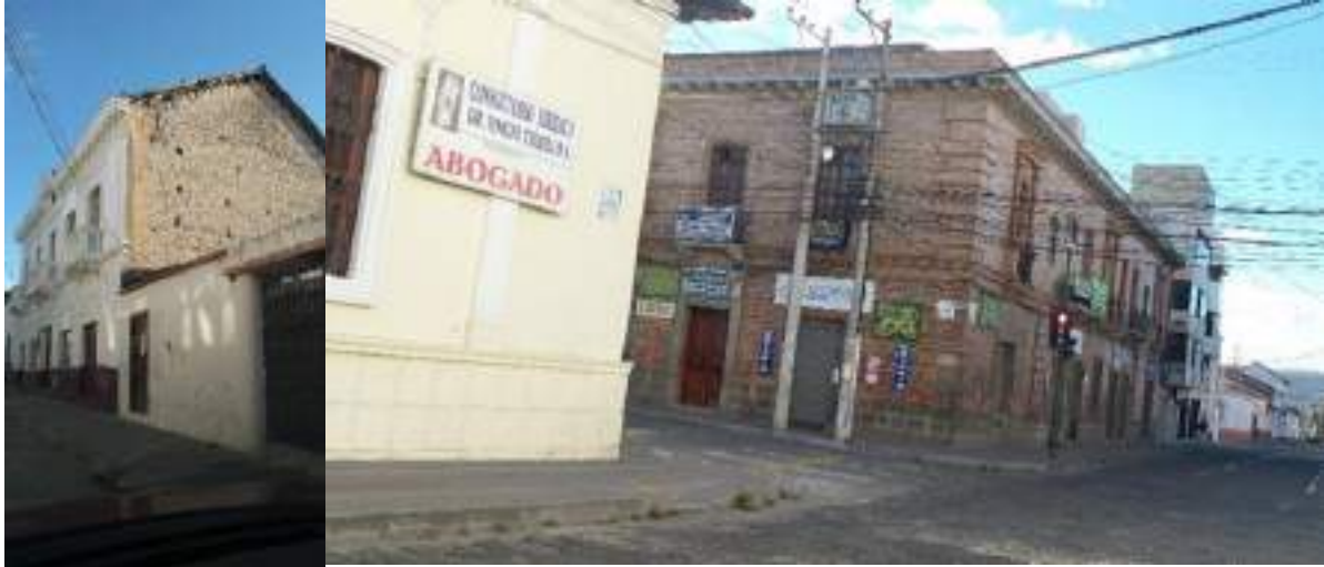
Imagen 7: Edificaciones de ladrillo y mixtas ladrillo-adobe en el Centro de Ibarra.
