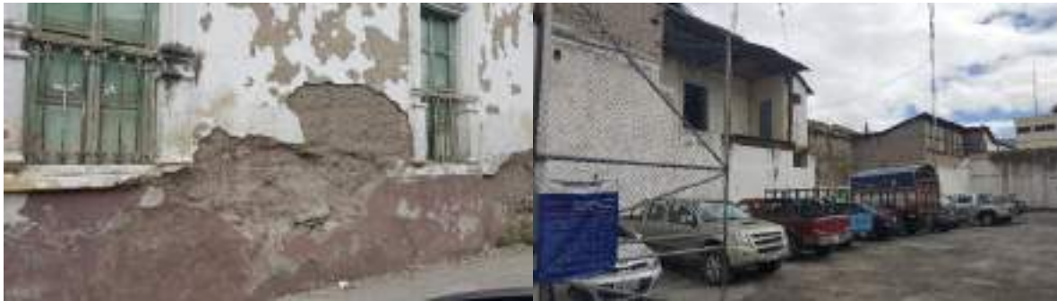
Imagen 5: Edificaciones de tapial y adobe en el centro de Ibarra
