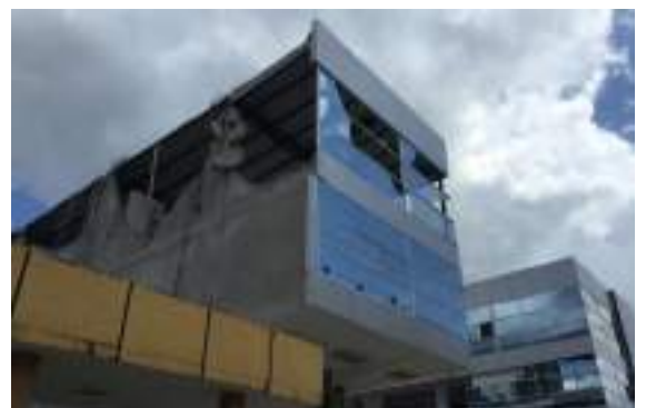
Imagen 17: Paredes falladas en ampliación con estructura metálica. Sismo de Manabí. (Suarez, 2016)
